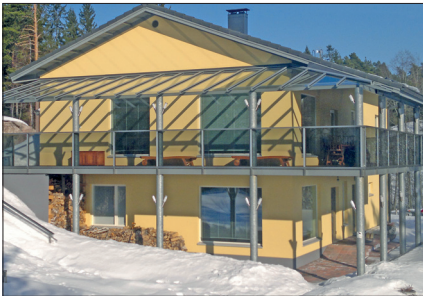
Kattolasitus jiirikulmalla, Vantaa
