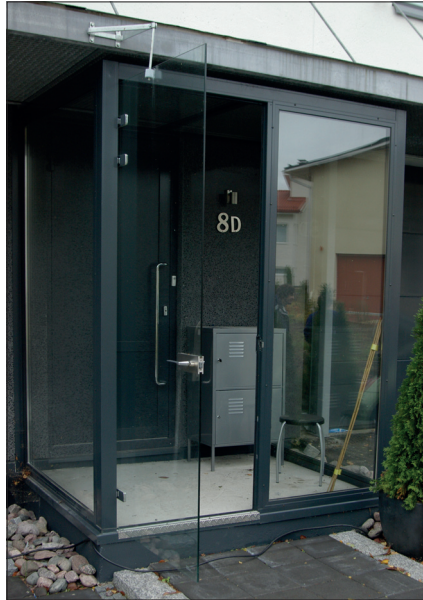
Tuulikaappi, joka on rakennettu Masi-lasitusjärjestelmällä
