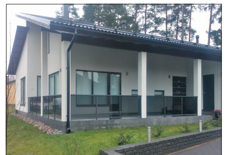
Terassin kaidelasitus Masi-yleisprofiililla, Vantaa
