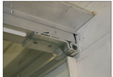
Kattokannakkeen kiinnitys seinään nivelkiskolla
